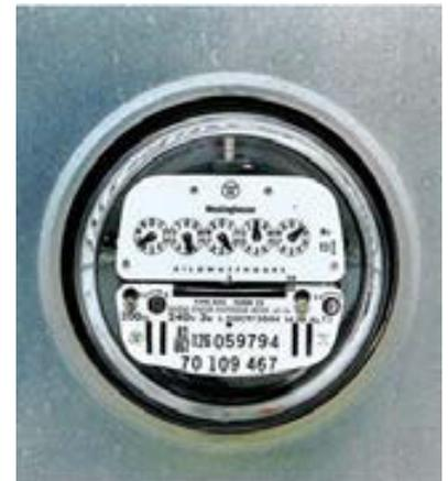
Este medidor eléctrico determina la energía utilizada en una casa o un negocio. Este medidor indica 65 401 kilowatts-hora.
